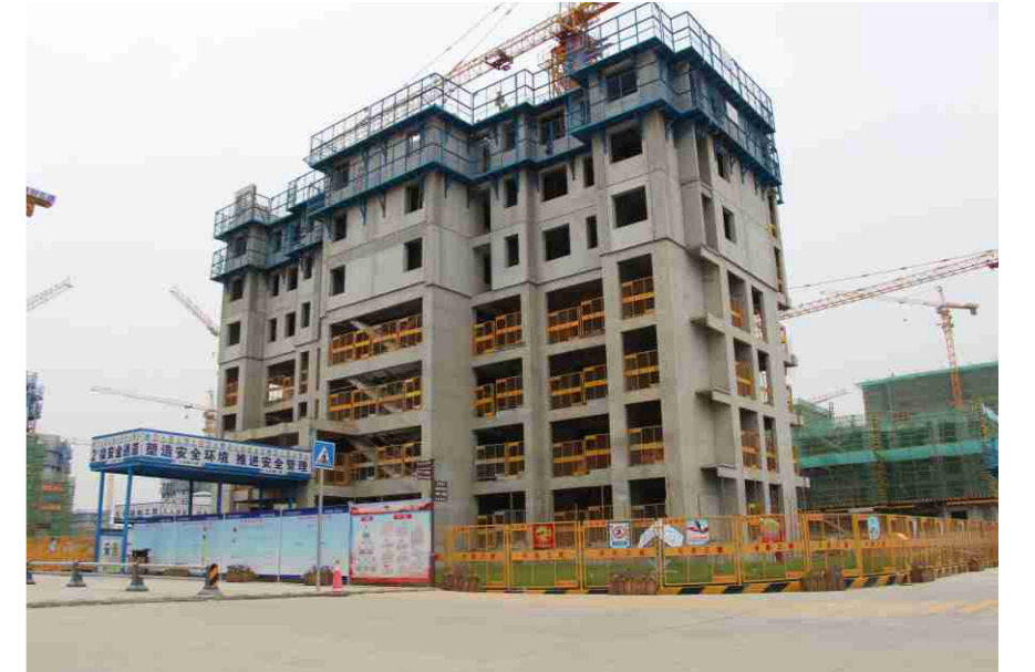
▲ 正在施工中的沁园项目（装配式）
