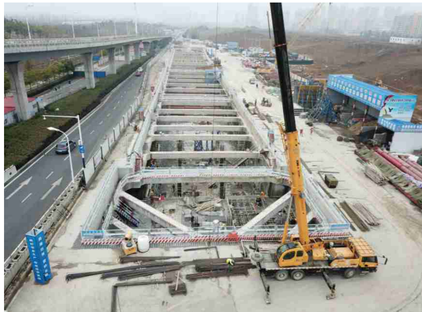
▼ 轨道交通四号线潜路口车站主体结构施工航拍
