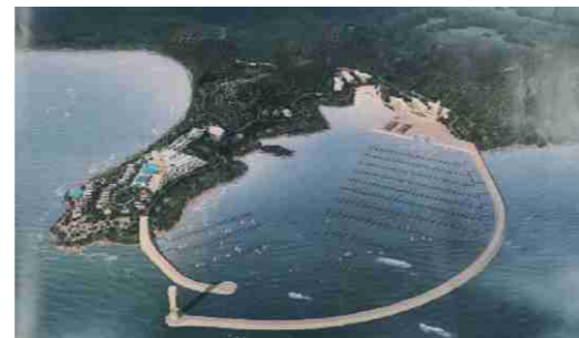
▼ 中国·浙江海洋运动中心（亚帆中心）工程
