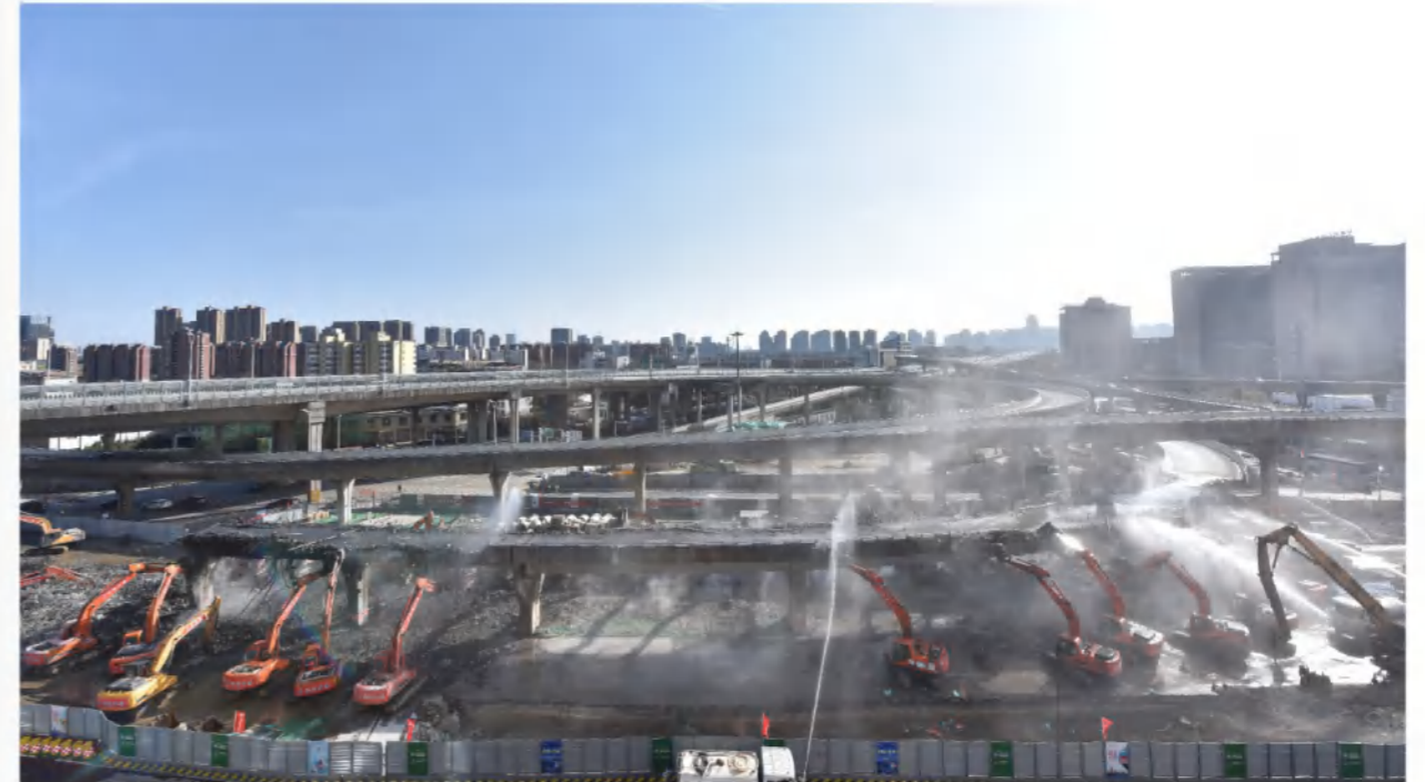
南二环与金寨路节点桥梁改造 ▲
