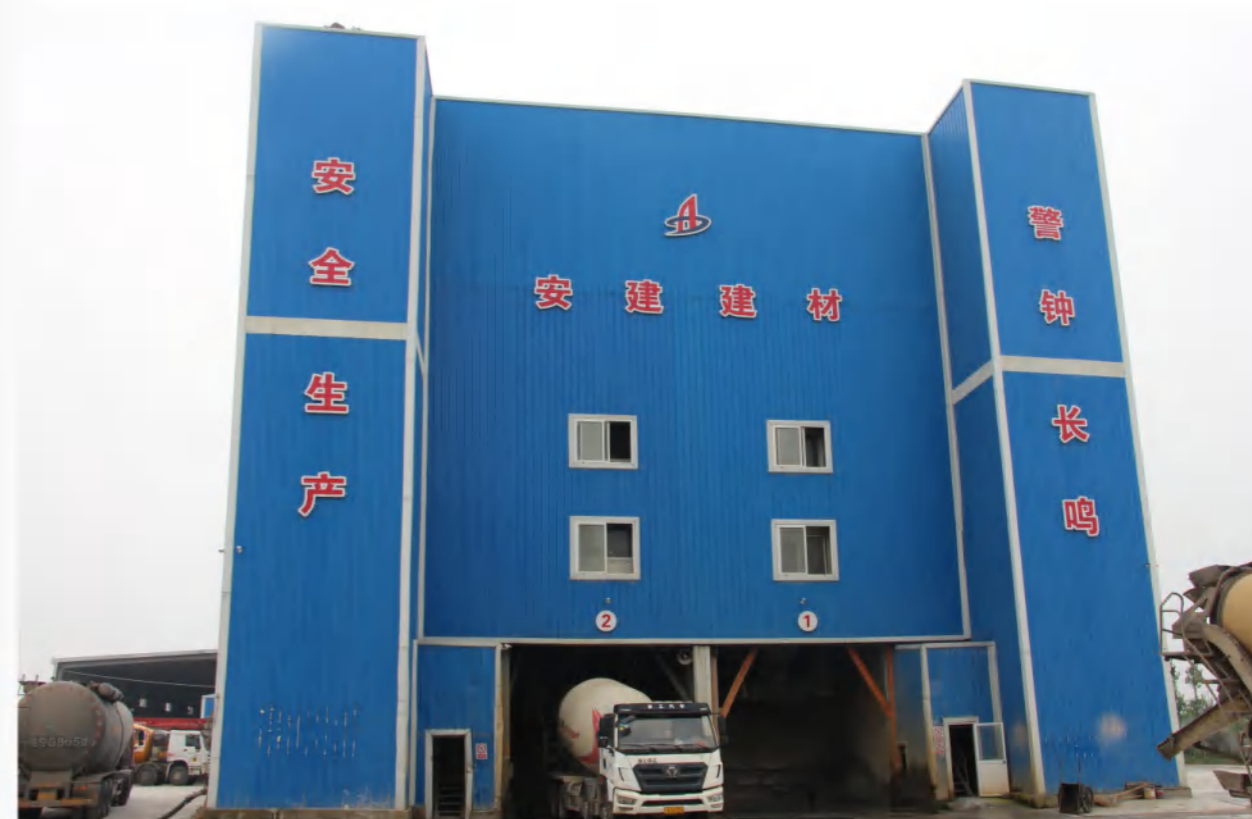
▲ 安建建材混凝土生产基地
