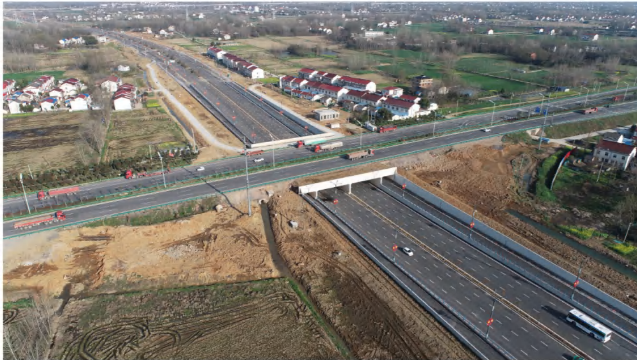
舒城三里河项目G206下穿隧道 ▲
