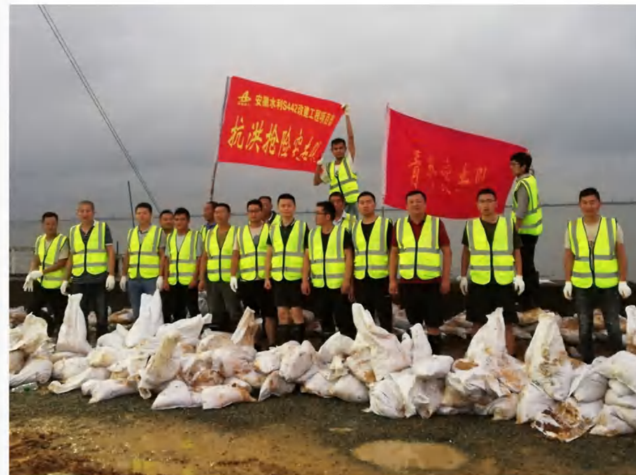
▲ 安徽水利S442项目抢险现场
