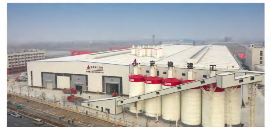
▼ 安徽建工吴山建筑工业化基地
