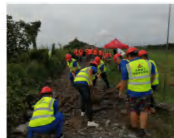
▲ 抢修防汛通道
