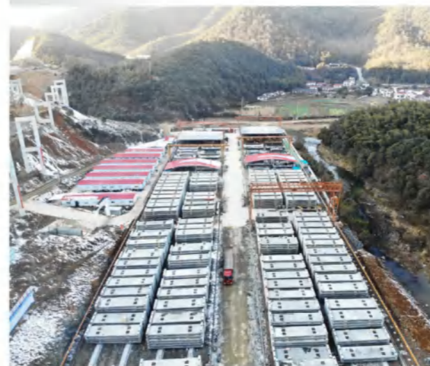
芜黄高速07标1#预制场桥面板预制 ▲
