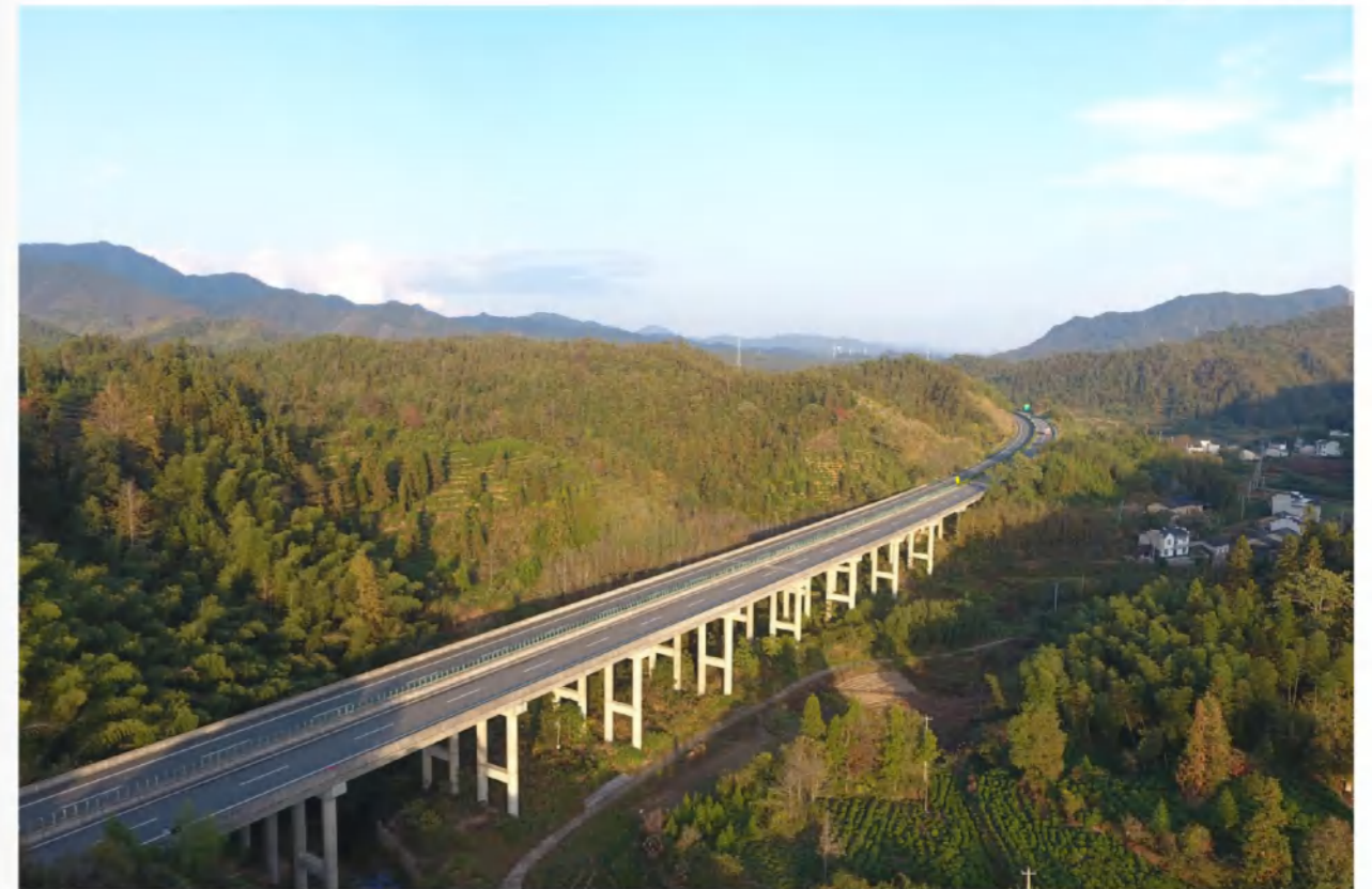
安徽路桥集团黄祁高速公路项目 ▼
