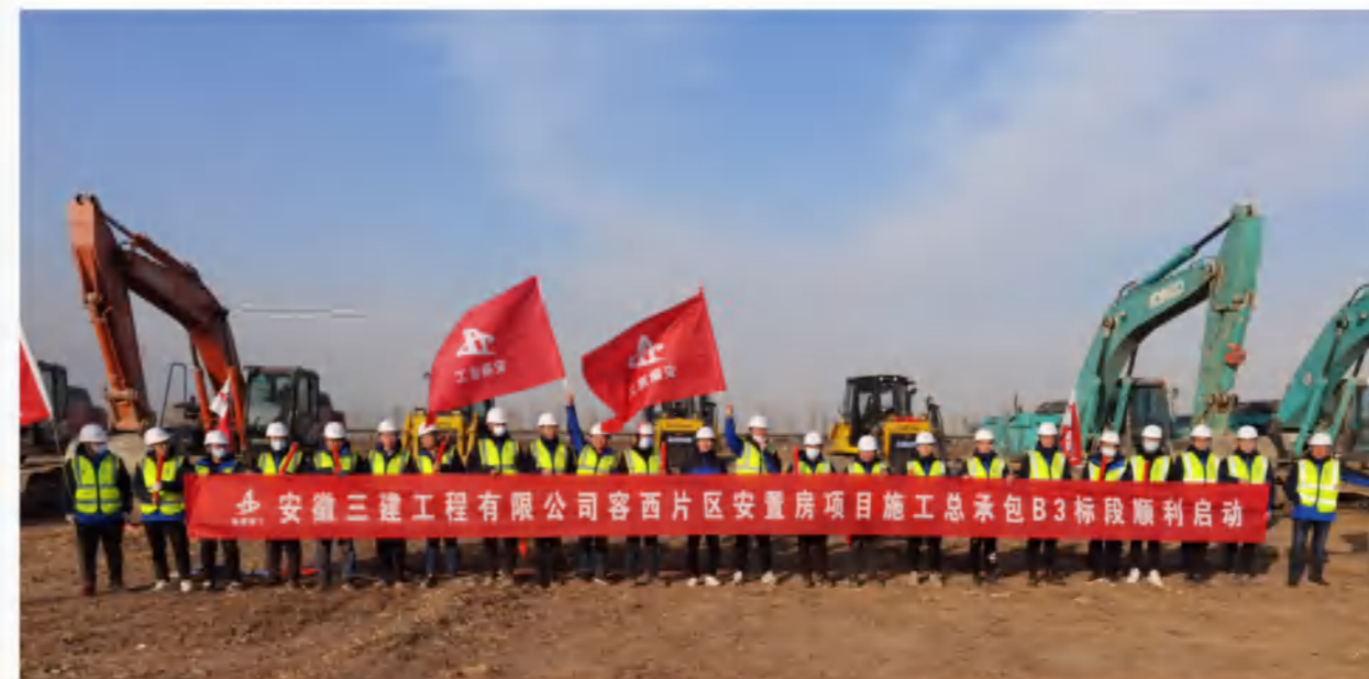
雄安新区容西安置房B3标段项目顺利开工
