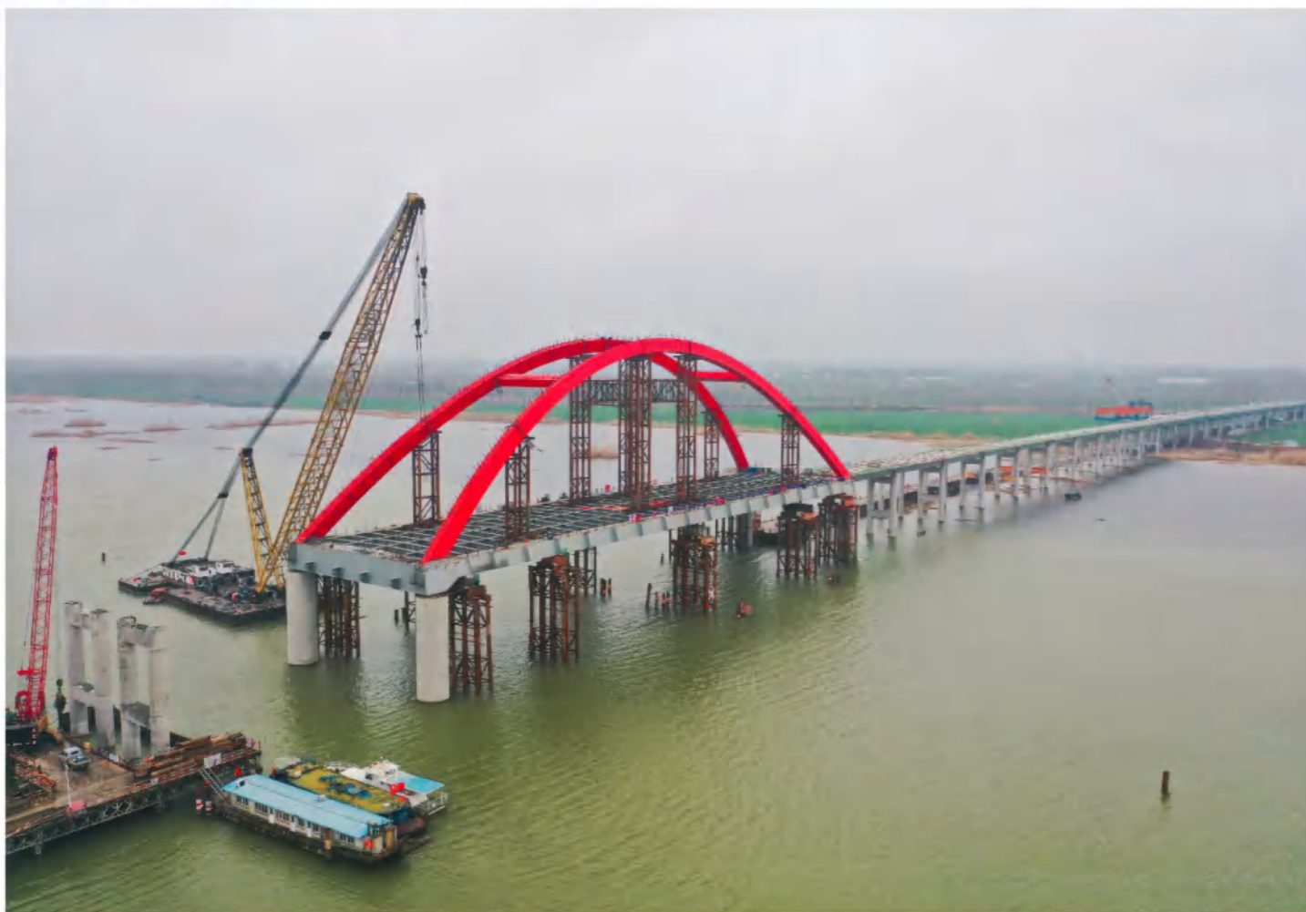
固蚌高速02标浍河特大桥 钢结构安装 ▼
