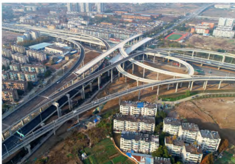
郎溪路05标桥梁主体工程完工 ▲
