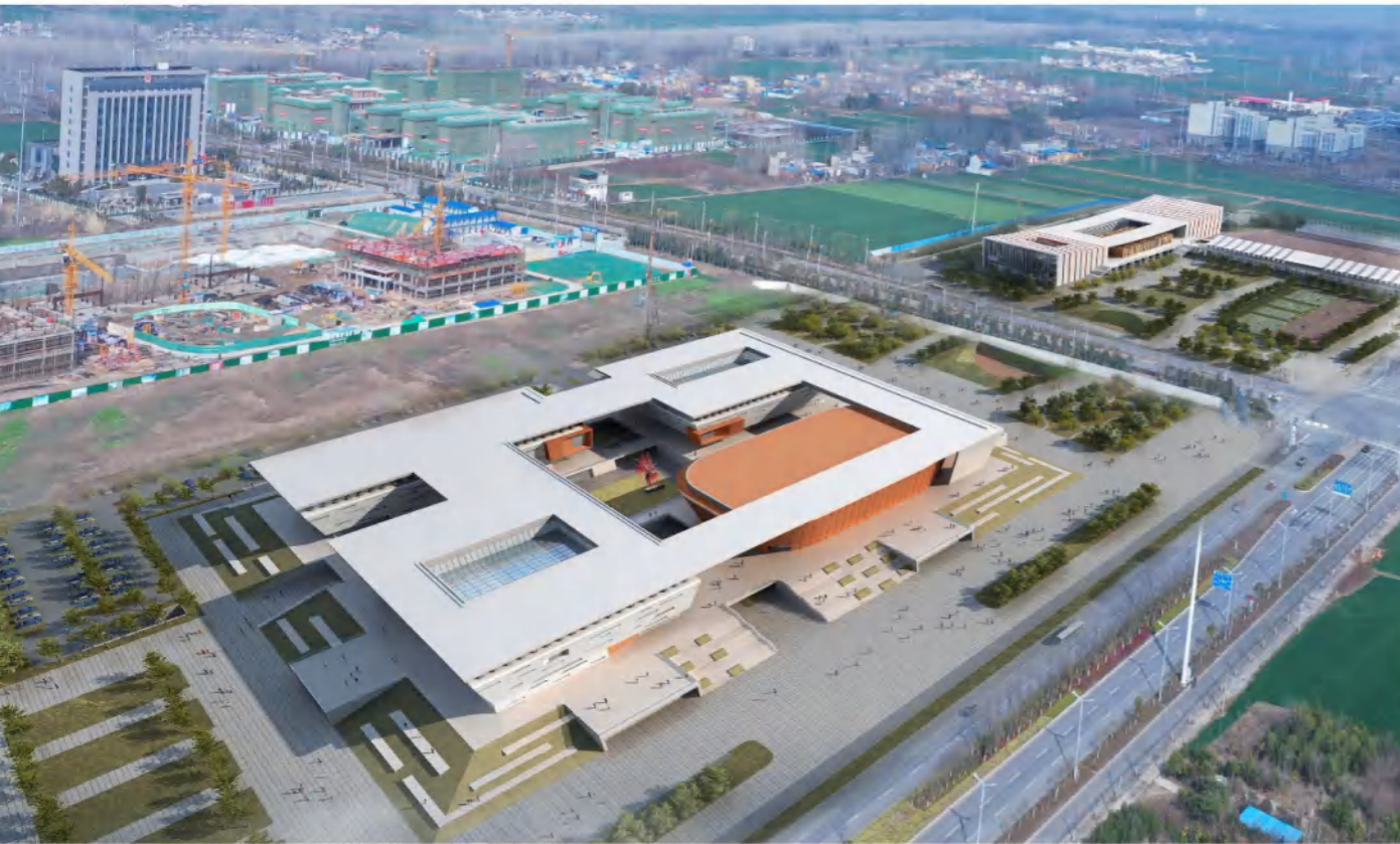
▲ 安徽二建宿州市埇桥区文化艺术中心暨三馆一院项目
