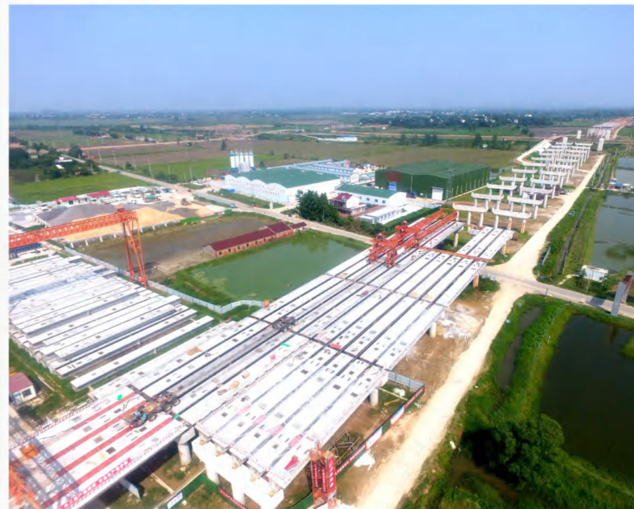
徽州大道项目罗埠河主桥箱梁架设 ▼
