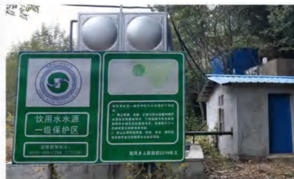
▲ 安徽建工集团资助趾凤村水厂设备间
