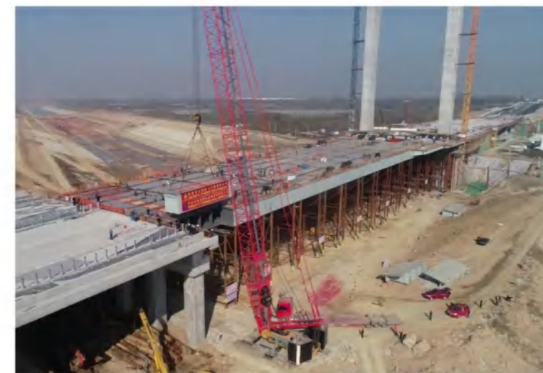
引江济淮（合肥段）3座市政桥梁工程二标钢箱梁合拢 ▲
