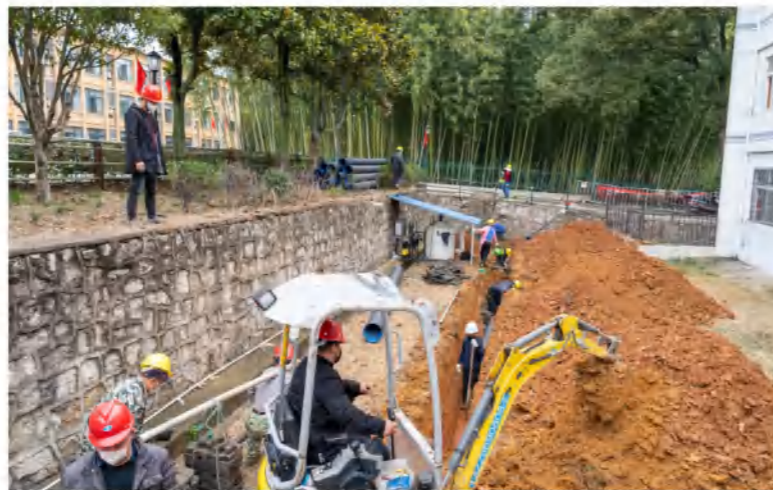
▲ 安徽三建半汤疗养基地改造工程管道安装
